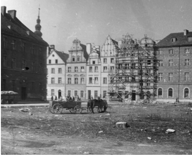
II.23. Renowacja kamieniczek przy ul. Brackiej, lata 50./60. XX w.
