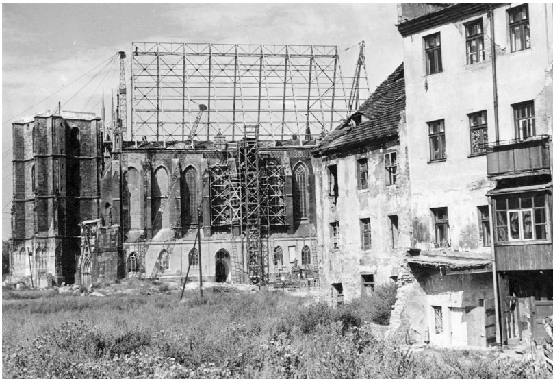
II.40. Drugi etap odbudowy kościoła św. Jakuba, widok od ul. Tkackiej, 1957/58 r.
