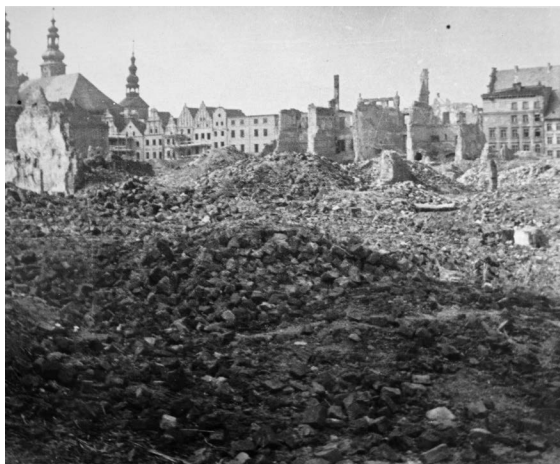
II.27. Śródmieście Nysy po odbudowie i pracach rozbiórkowych, widok od ul. Tkackiej, druga połowa lat 50. XX w.
