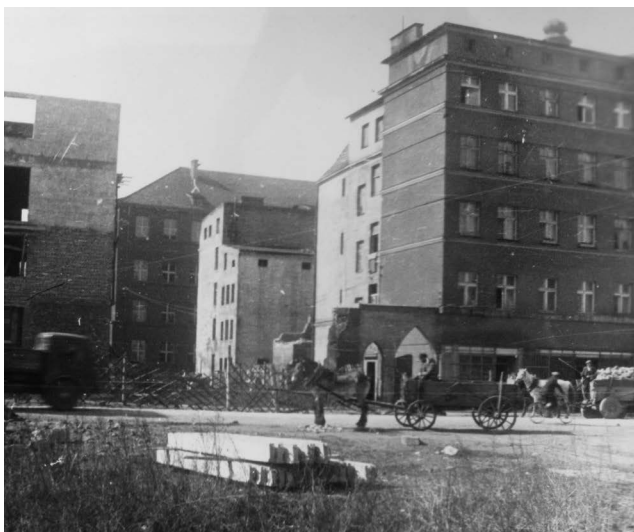
II.35. Budowa bloku mieszkalnego przy ul. Celnej 10, 1956–1957 r.
