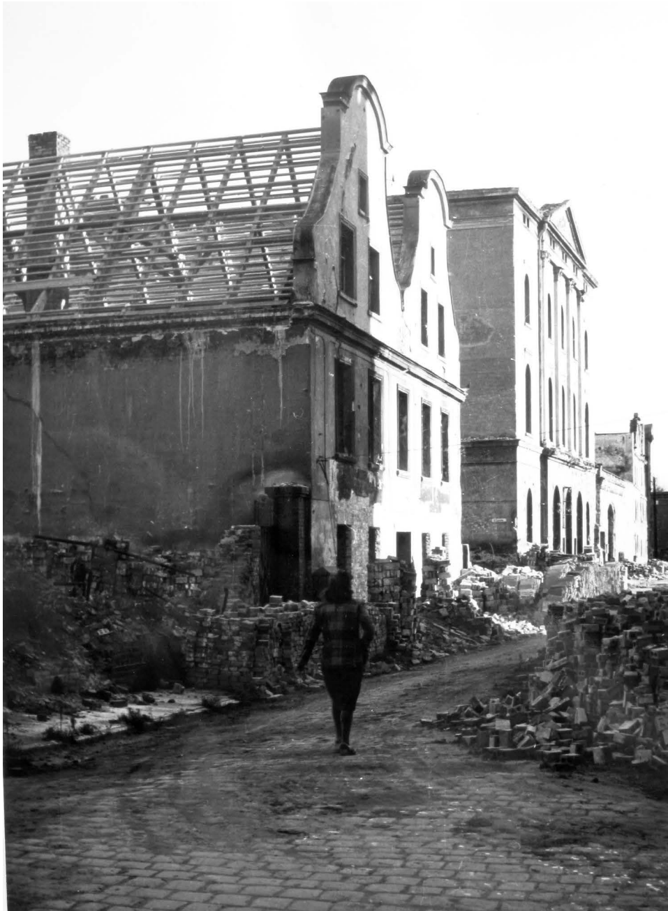
II.15. Odbudowa bliźniaczej kamieniczki przy ul. Wałowej, ok. 1949 r. (?)
