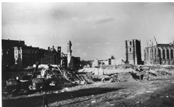
II.28. Śródmieście po rozebraniu południowo-wschodniej pierzei Rynku, widok w stronę ul. Wrocławskiej, lata 50. XX w. (przed marcem 1957 r.)
