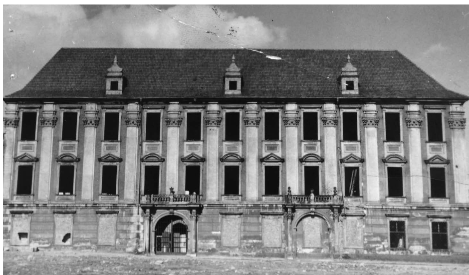
II.20. Pałac biskupi po pracach zabezpieczających, lata 50. (?) XX w.
