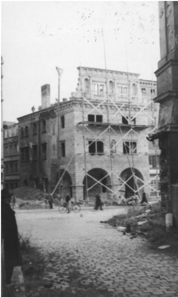
II.7. Odbudowa Domu Wagi Miejskiej, 1947–1948 r.
