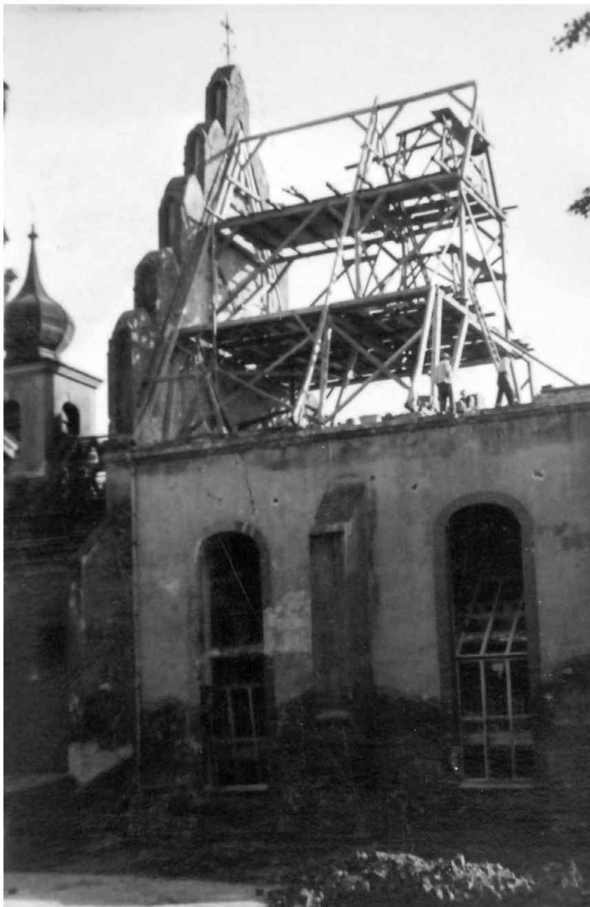
II.2. Odbudowa dachu kościoła św. Barbary, 1947 r. (?)
