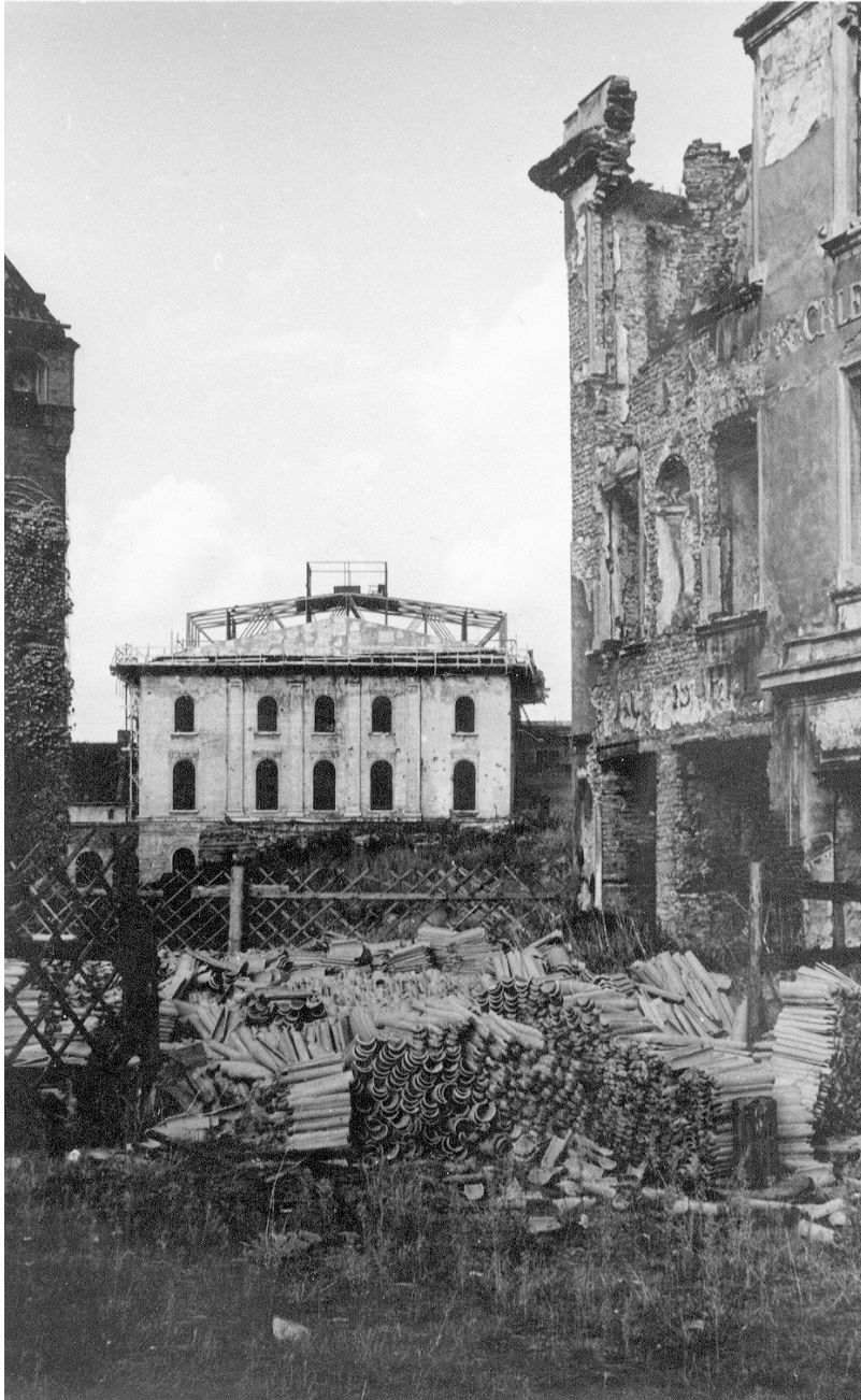
II.18. Budynek dawnego Teatru Miejskiego w trakcie odbudowy, 1958 r. (?)
