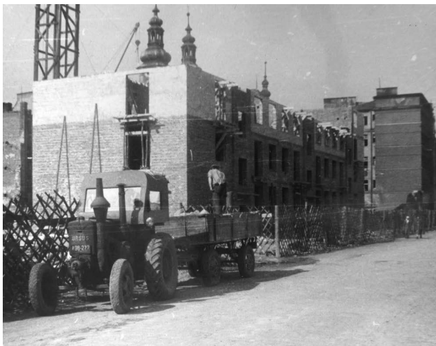
II.34. Budowa bloku mieszkalnego przy ul. Celnej, 1956–1957 r.
