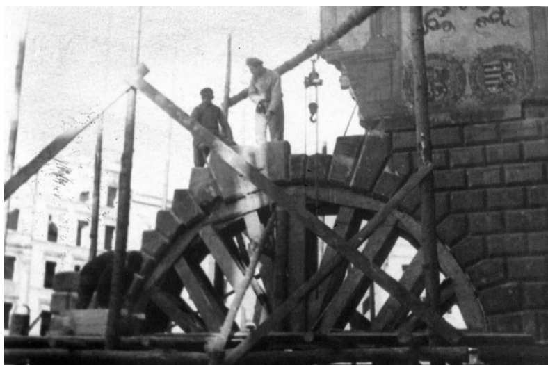
II.6. Pierwszy etap odbudowy Domu Wagi Miejskiej, 1947 r.
