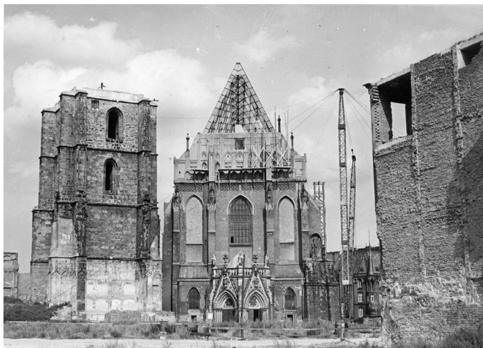
II.38. Drugi etap odbudowy kościoła św. Jakuba, widok od strony Rynku, 1957/58 r.
