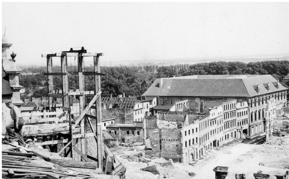
II.19. Odbudowa i postępująca destrukcja zabudowy ul. Biskupa Jarosława, ok. 1949–1950 r. (?)
