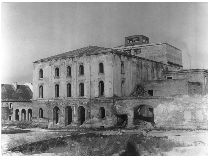
II.43. Budynek dawnego Teatru Miejskiego w trakcie kolejnej próby odbudowy, 1960 r.
