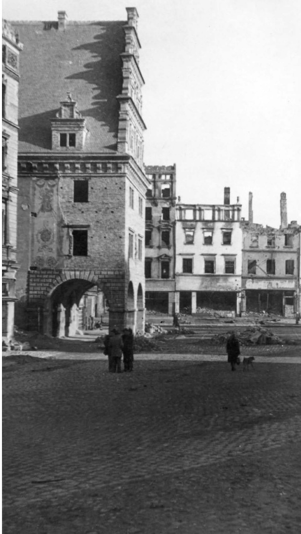
II.10. Odbudowany Dom Wagi Miejskiej na tle ruin południowo-wschodniej pierzei Rynku, lata 50. XX w. (przed 1957 r.)
