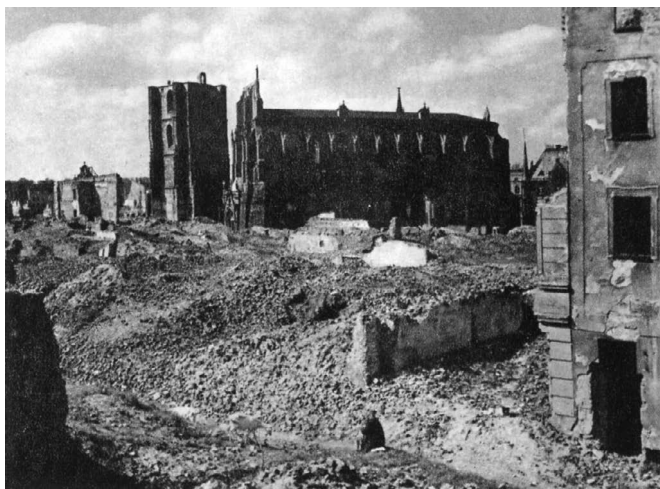
II.26. Śródmieście po pracach rozbiórkowych, przed marcem 1957 r.
