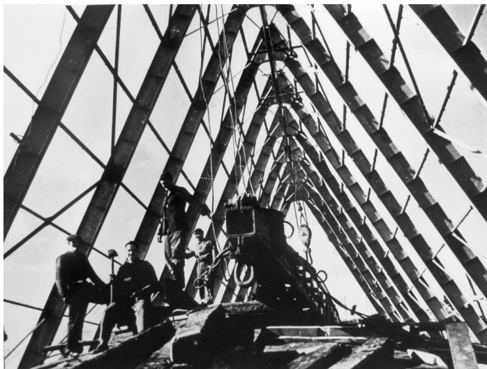
II.37. Montaż stalowej konstrukcji dachu kościoła św. Jakuba, 1957 r.
