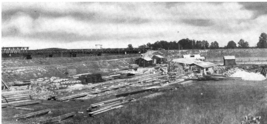
Ryc. 1. Skład materiałów do budowy mostu w Krobielewku – lewy brzeg Warty, źródło: Pommerrenig, Holzbrücke , s. 162.
