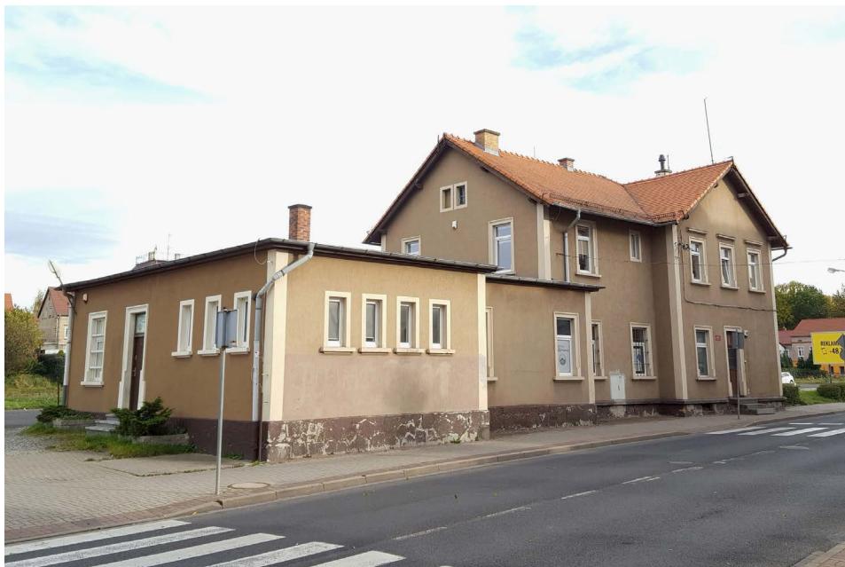
Il. 8. Dawny budynek dworca kolei wąskotorowej w Bogatyni. 20 X 2021 r. Fot. Paweł Jakuboszczak.
