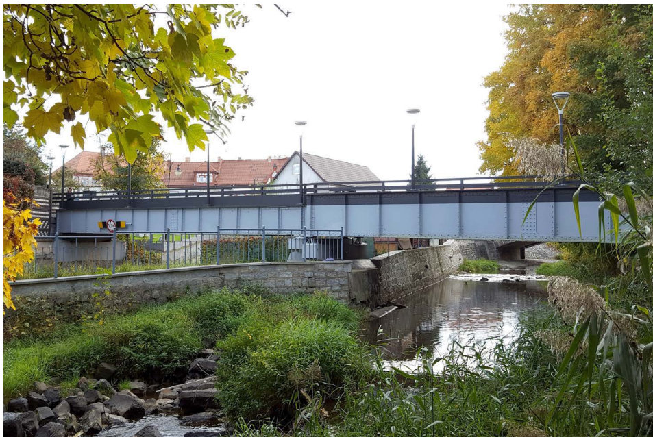
Il. 7. Most kolejowy nad rzeką Miedzianą w Bogatyni. Obecnie kładka dla pieszych. 20 X 2021 r. Fot. Paweł Jakuboszczak.
