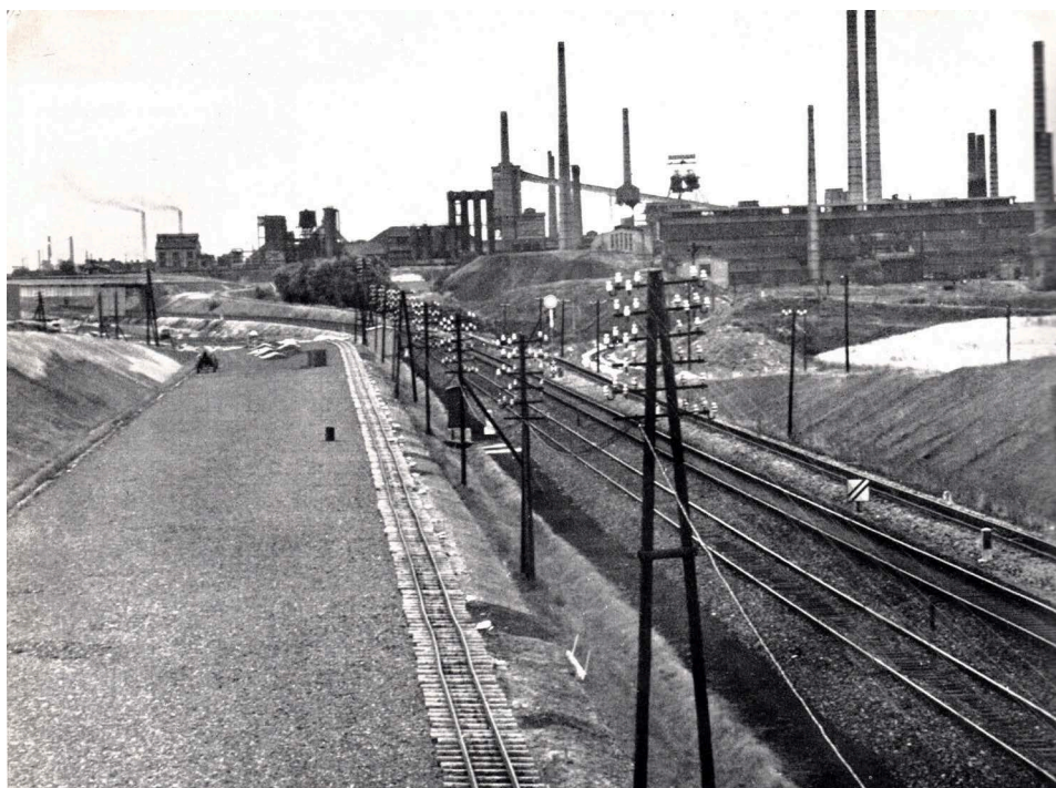
Bild 7. Baustrecke 64 nördlich Hindenburg zwischen Bau-km 10,2 und 12,0, Blick zur Donnersmarckhütte.
